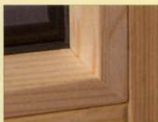
Νέα μέθοδος με ράγα FIXclip (χωρίς ορατά καρφιά και με σφικτή συναρμογή)
